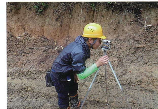
測量調査(南部町東上)
