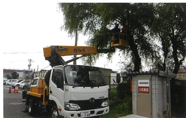
高所作業車を用いての伐採
